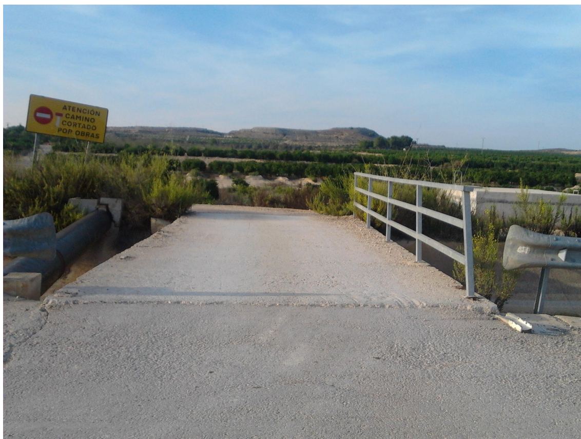
Foto 10: Puente que atraviesa el canal del Trasvase Tajo-Segura
